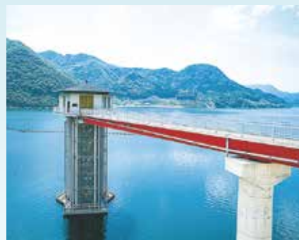
▲8市9町に水を供給する重要な水がめ「七ヶ宿ダム」
